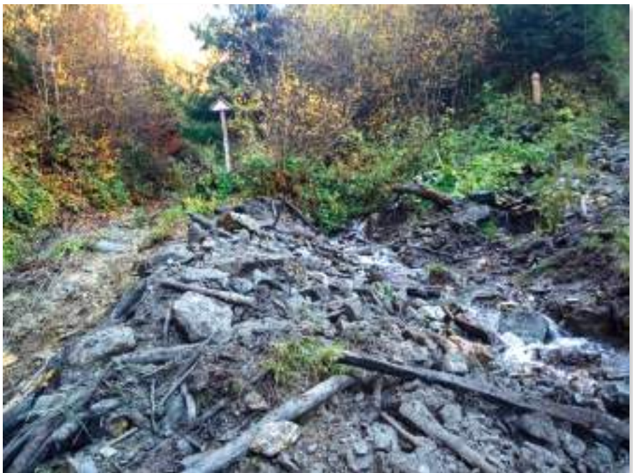
Фото 16. Розчищене русло потоку Довгарунь, по якому тече вода, та відновлена лісова дорога.
